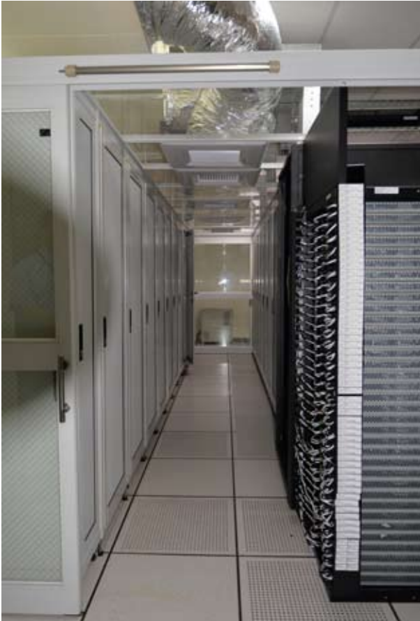
冷熱通道讓冷氣集中施放，達到重點有效降溫而節能的效果。
